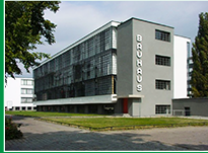
bâtiment, Walter GROPIUS, 1925-1926
