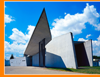
caserne de pompiers, Zaha HADID, 1994
